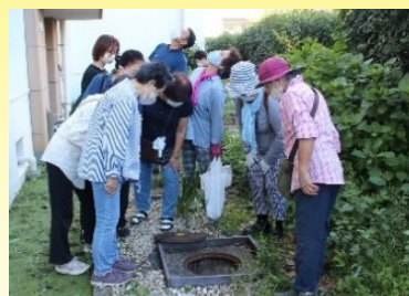
奇数・偶数両系統の 污水管破断確認
